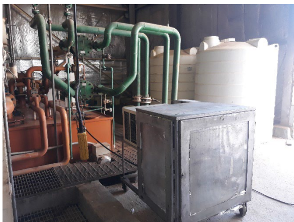
سامانه حذف ذرات و وارنیش RNA-VRS-02 در کنار مخزن توربین
