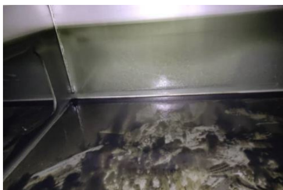
رسوب وارنیش در مخزن روغن توربین
