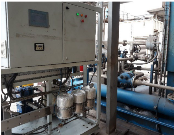
سامانه حذف وارنیش بر روی سیستم روانکاری توربو اکسپندر
